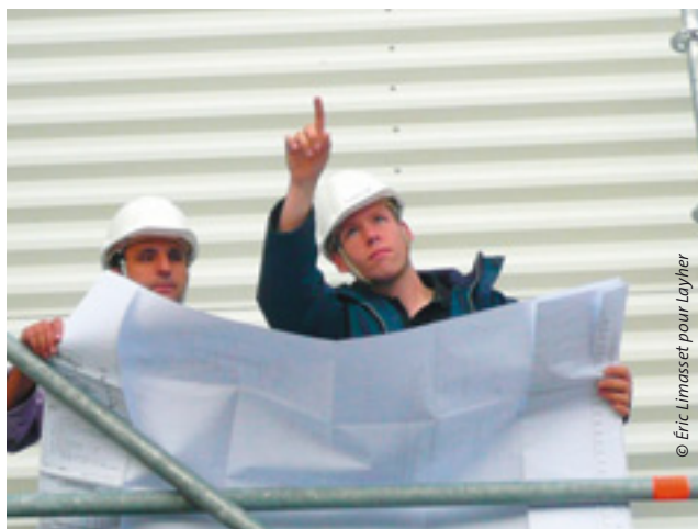
23. Examen du plan de montage de l'échafaudage.
