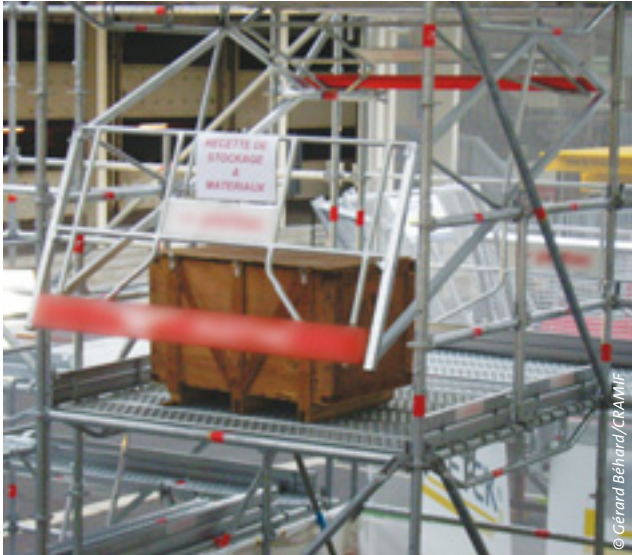
13. Approvisionnement en sécurité à l'aide d'une barrière « écluse ».
