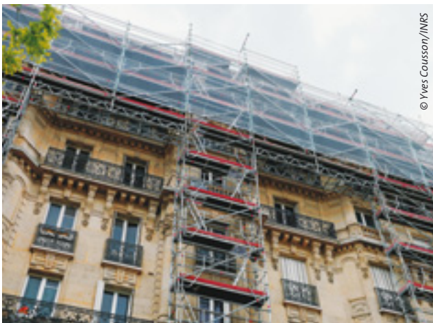
14. Échafaudage sur sapines desservant les derniers niveaux et servant de protection bas de pente pour les travaux de couverture.
