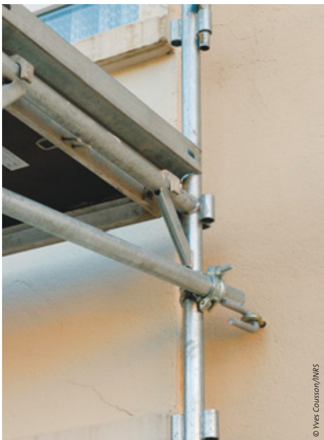
10. Détail d'un point d'ancrage.
