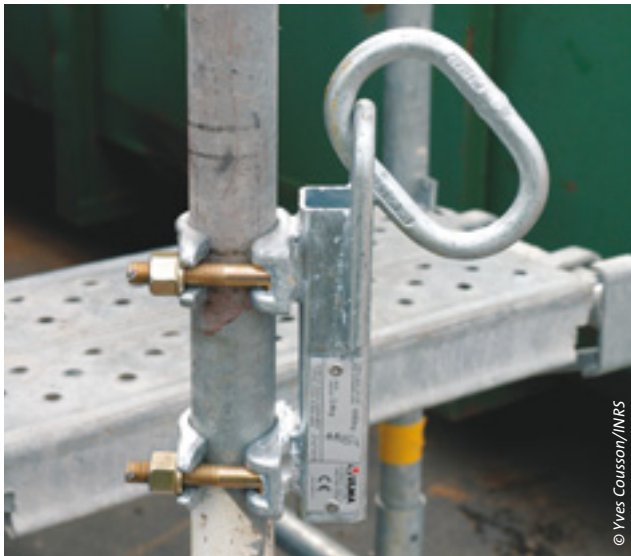
9. Point de levage d'un échafaudage.
