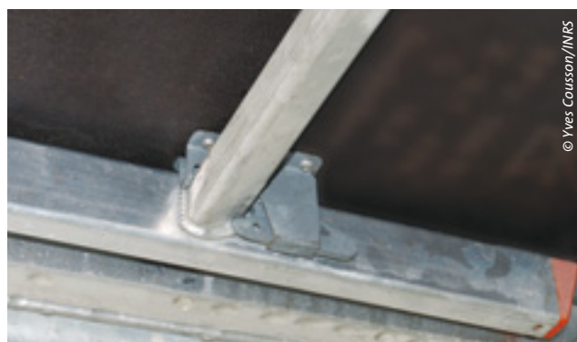
22. Détail de la fixation du pied d'échelle sous un plancher.
