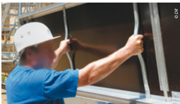
17. Profilés sous le plancher facilitant sa manutention.
