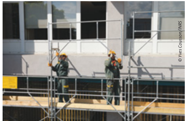
16. Mise en place du garde-corps MDS depuis le niveau inférieur.
