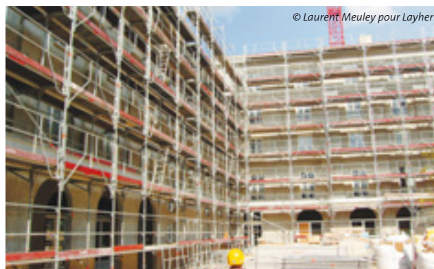
2. Chantier équipé d'un échafaudage MDS.
