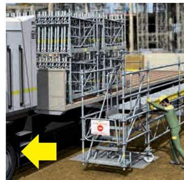
Lorsque le véhicule est stationné, déplacez le quai contre la remorque, puis serrez les freins. Seules 2 surfaces de roulement suffisent. Ces surfaces doivent être horizontales.
