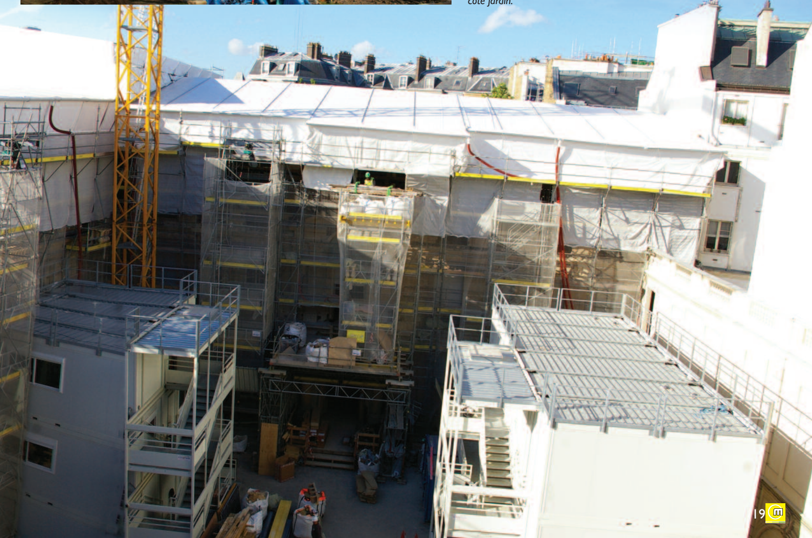
Façade et parapluie en cours de montage côté jardin.
