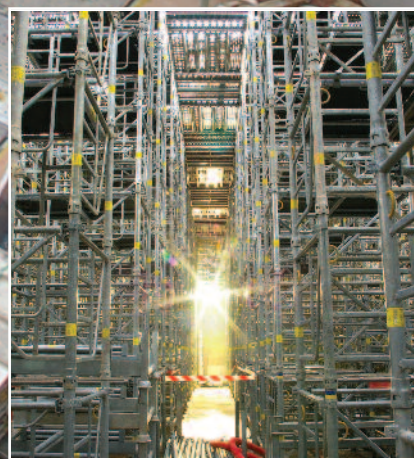
Etalement Touréchaf avec platelage entre tours pour les opérations de coffrage de poutres, passage Delessert à Paris.
