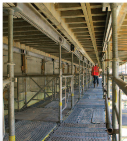
La circulation entre tours est aisée et le décoffrage simplifié.
