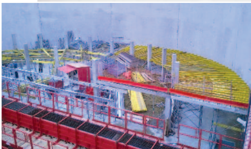
Coffrage circulaire des accès du parking.
