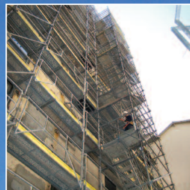
Escalier de chantier dans la cour intérieure.
