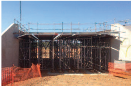
Echafaudage de service Mills Acram MDS sur les piles des ouvrages d'art.
