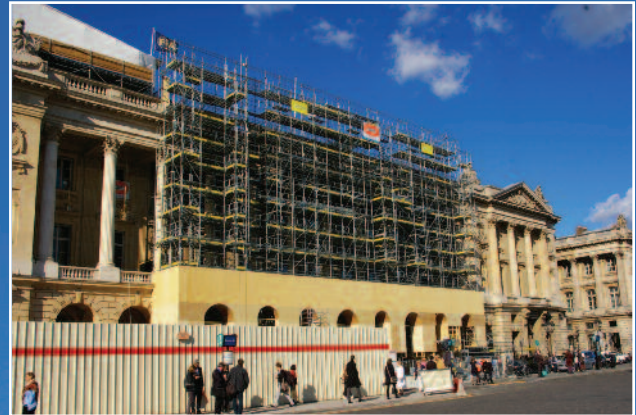
Les usagers accèdent au métro au pied de l'échafaudage
