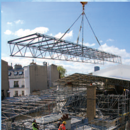
Mise en œuvre des caissons de charpente CK 800 précédemment assemblés sur une aire de montage dans les jardins
