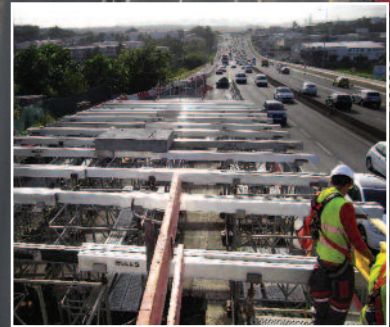
Réglage des poutrelles Mills Phal.
