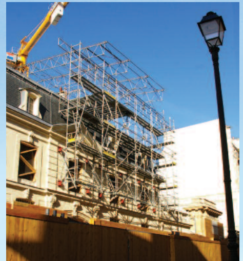
Sur la rue, l'échafaudage Mills Acram MDS et le parapluie sont suspendus au-dessus de l'accès réservé aux camions de livraison.
