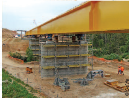
Echafaudage de service Mills Acram MDS sur les piles des ouvrages d'art.
