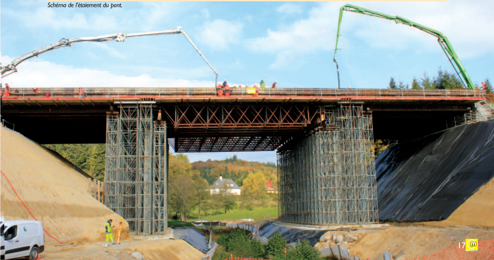
Schéma de l'étalement du pont.
