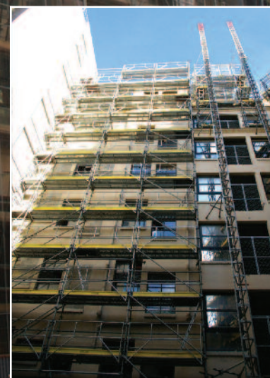
Un lift permet d'acheminer les matériaux.
