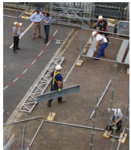
L'après-midi, les candidats réalisent les épreuves pratiques de montage et démontage de l'échafaudage sous l'œil du jury.
