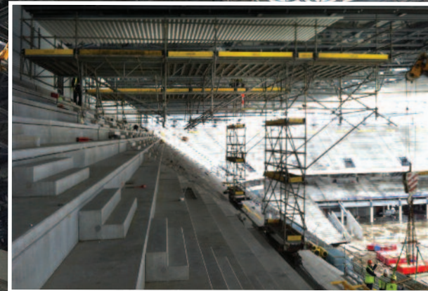
Plateformes roulantes sous la charpente de la toiture.
