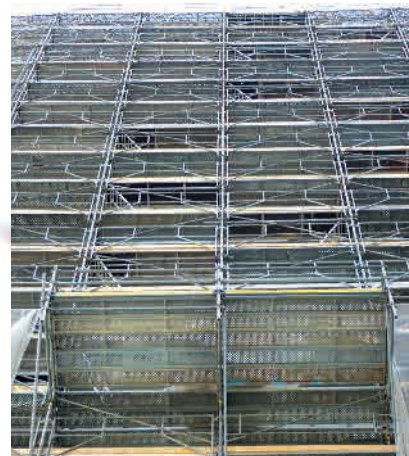
Des recettes à matériaux ont été installées pour faciliter l'approvisionnement.
