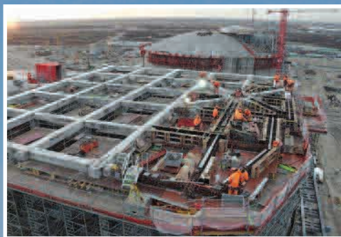
Les compagnons réalisent les poutres couléées en place en toute sécurité.
