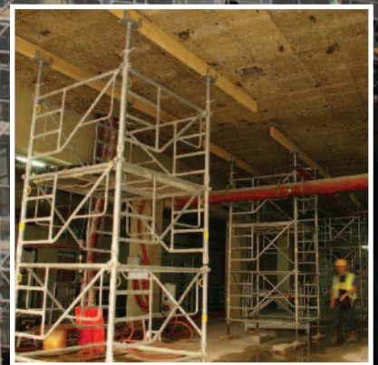
Etaieiment Touréchaf pour maintenir la superstructure.
