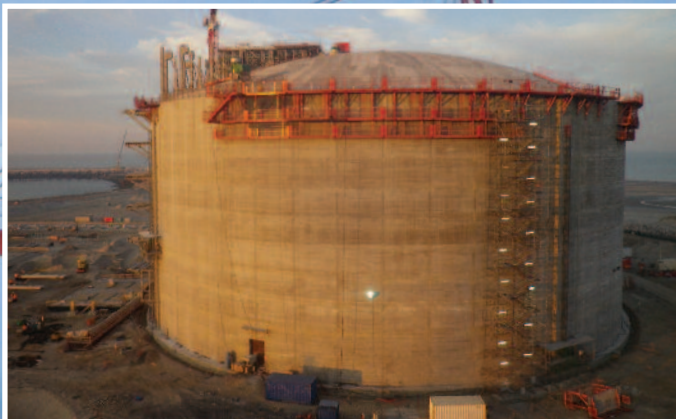
Les plots de Touréchaf sont préfabriqués au sol et levés à la grue à 60 m sur le sommet du réservoir.
