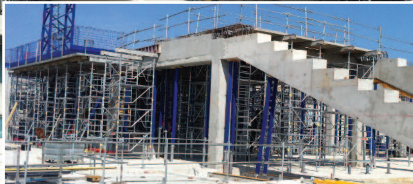
Tourécharf pour la pose des gradins.
