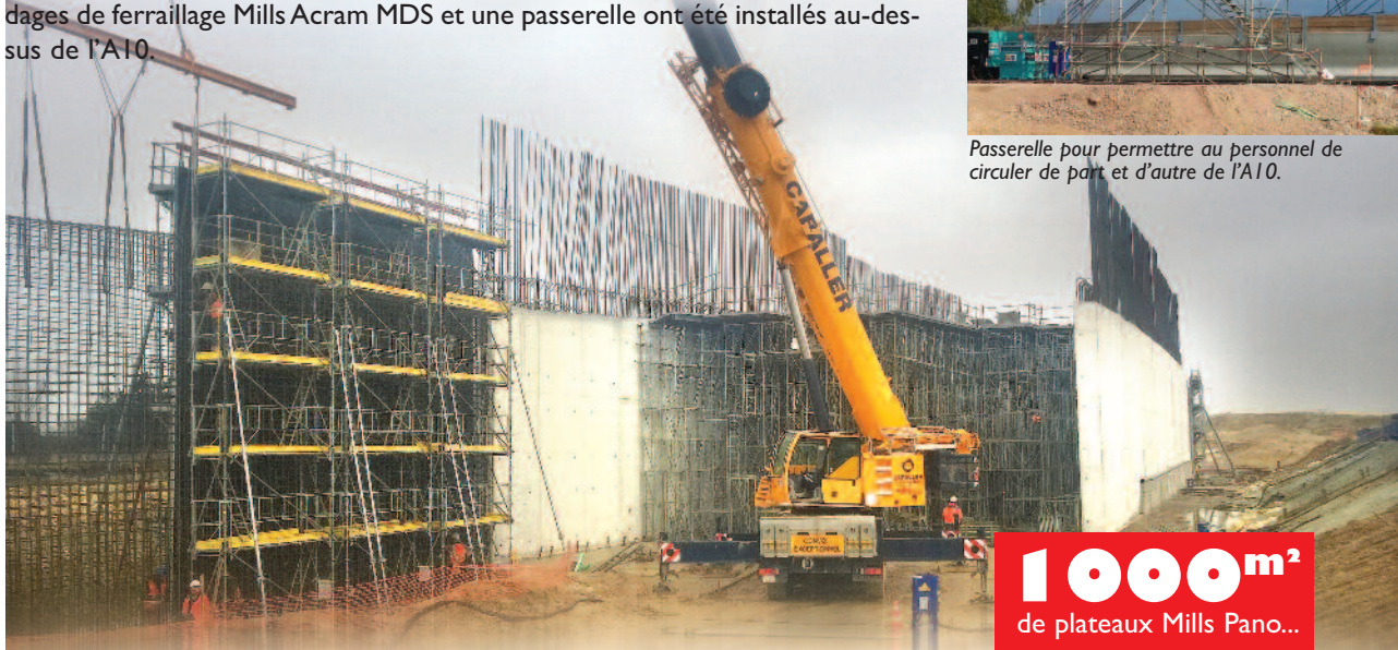
Vue d'un échafaudage de ferrailage et d'un étaieement Mills Tour équipé de plateaux Mills Pano.
