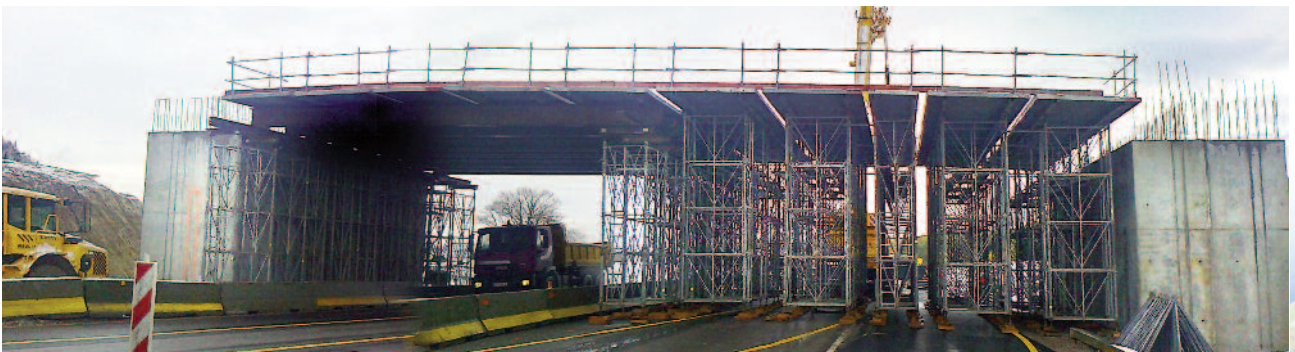
Schéma de principe des Touréchaf liaisonnées avec planchers de travail en tête et en sécurité.
