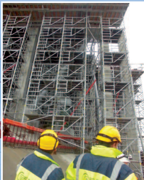
Les Touréchaf sont liaisonnés avec un platelage complet en tête de tours pour la pose des plateaux.
