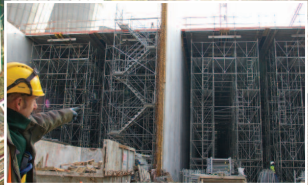
Les plateaux Mills Pano sont posés à 12.50 m de haut.
