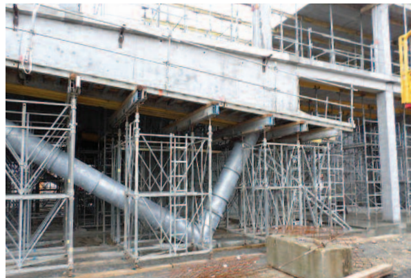
Etalement incliné du porte à faux.
