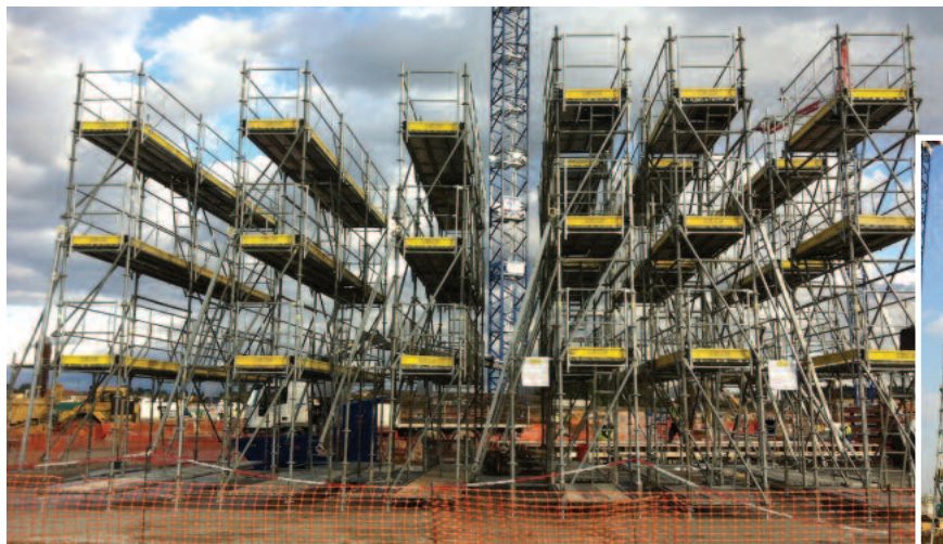
Tourécharf pour la pose des gradins.
